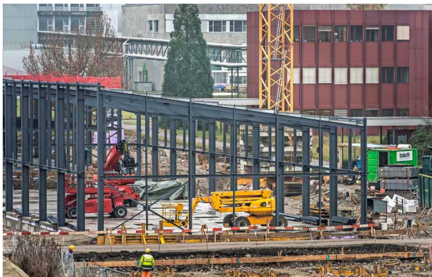
Une société catalane construit les structures métalliques des cinq halles du futur centre artisanal du MIC. Alain Wicht
