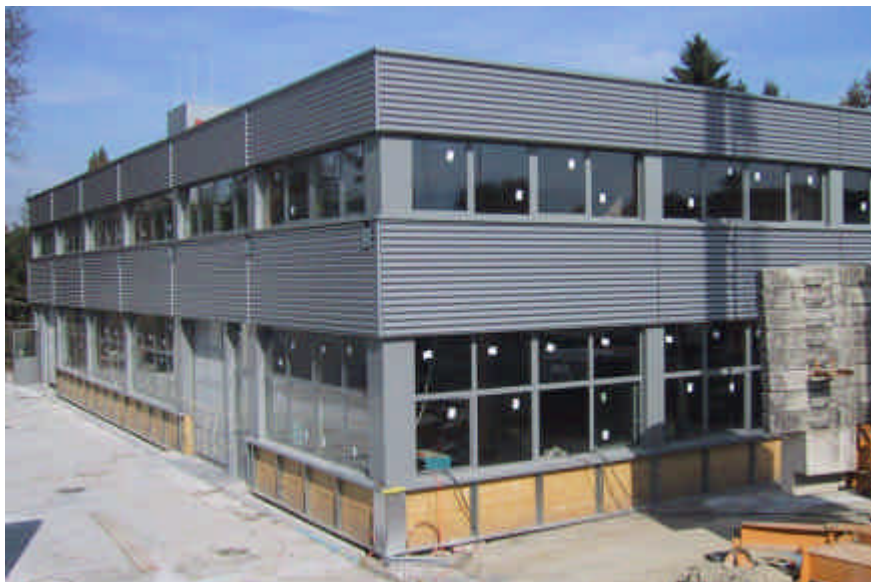
La façade totalement relookée de la nouvelle halle des maçons
