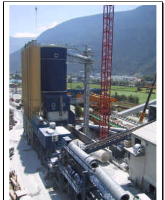
Les imposantes installations de chantier, à l'entrée du tunnel côté Rarogne (photo JDW)
