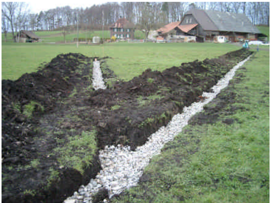
Travaux de drainage pouvant être réalisés avec peu de moyens
